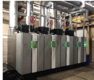
※ ボイラー：水などの液体を加熱することで蒸気や温水をつくる機械
